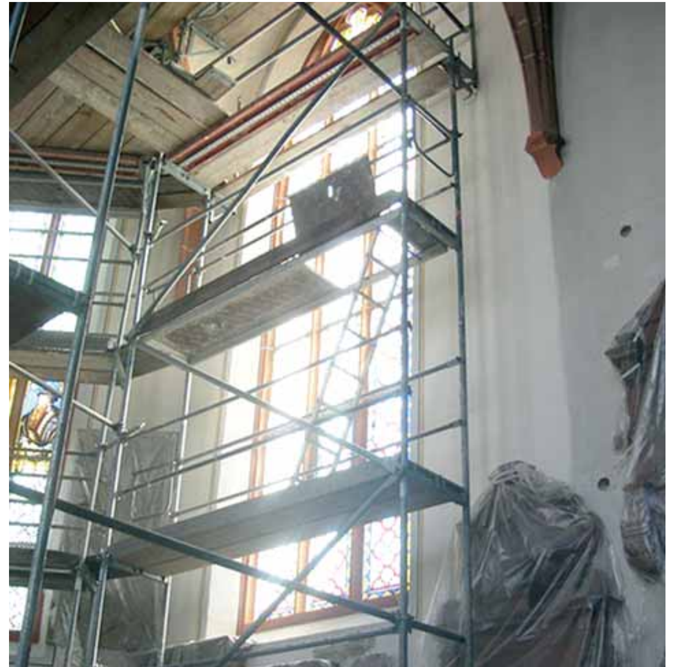
Beginn der Renovierungsarbeiten, 1. Farbmusterachse
