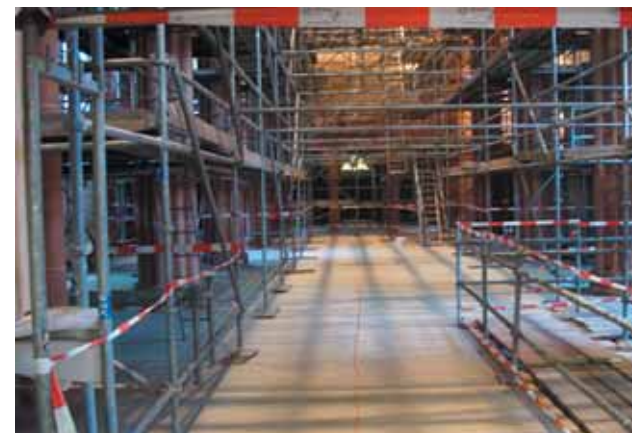
Langhaus während der Renovierung
