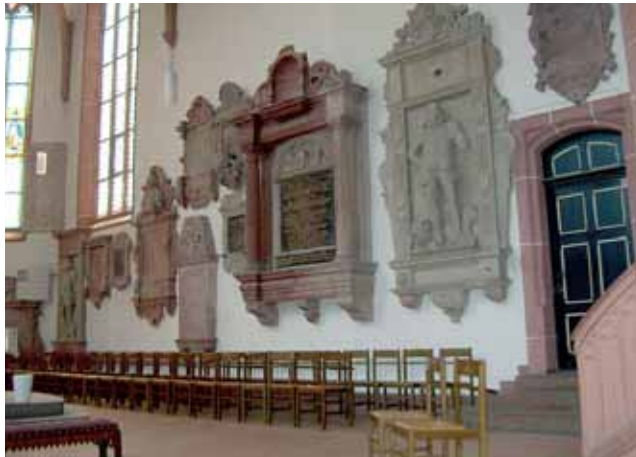
Chorraum Süd vor der Renovierung
